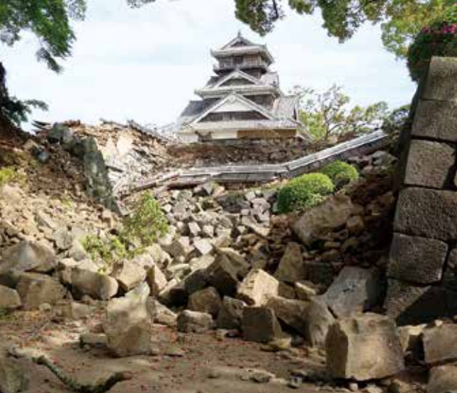
熊本城では石垣が崩落
