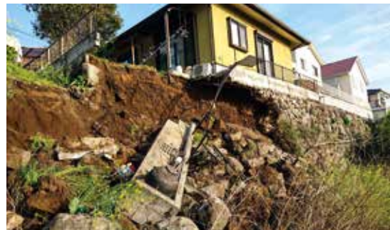
別府市内各地で被害が発生
