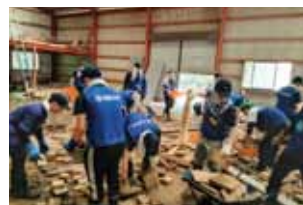
材木所に散乱した木片の片付け
