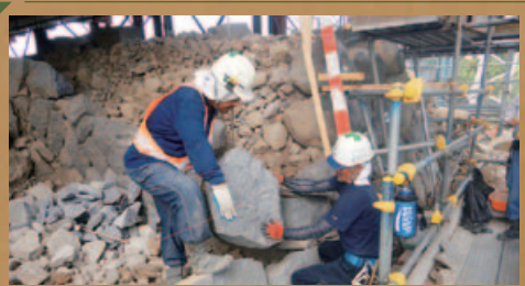
熊本城大天守閣の石垣積み直し作業の様子。災害に遭う前の完全復元を目指すには、当時の計測データが必須となります。
