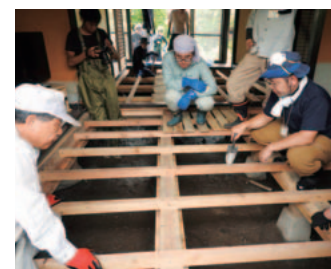
廣瀬資料館の畳を上げて土砂を除去
