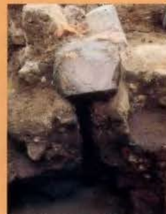
御殿の一角をなす御殿長屋の礎石下から、杭痕。御殿の下部構造が分かる例で、木杭の使用例は全国初の発見。杭の材質は、やっぱり、松(クロマツ)。
