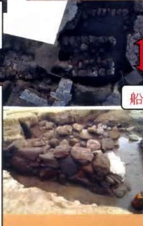
御殿の一角をなす御殿長屋の礎石下から、杭痕。御殿の下部構造が分かる例で、木杭の使用例は全国初の発見。杭の材質は、やっぱり、松(クロマツ)。
